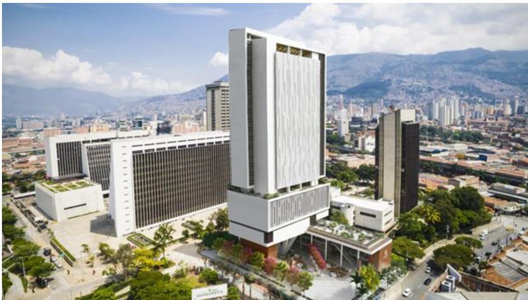
Ilustración 2: Vista general del nuevo edificio de tribunales de Medellín Fuente: ANIM
